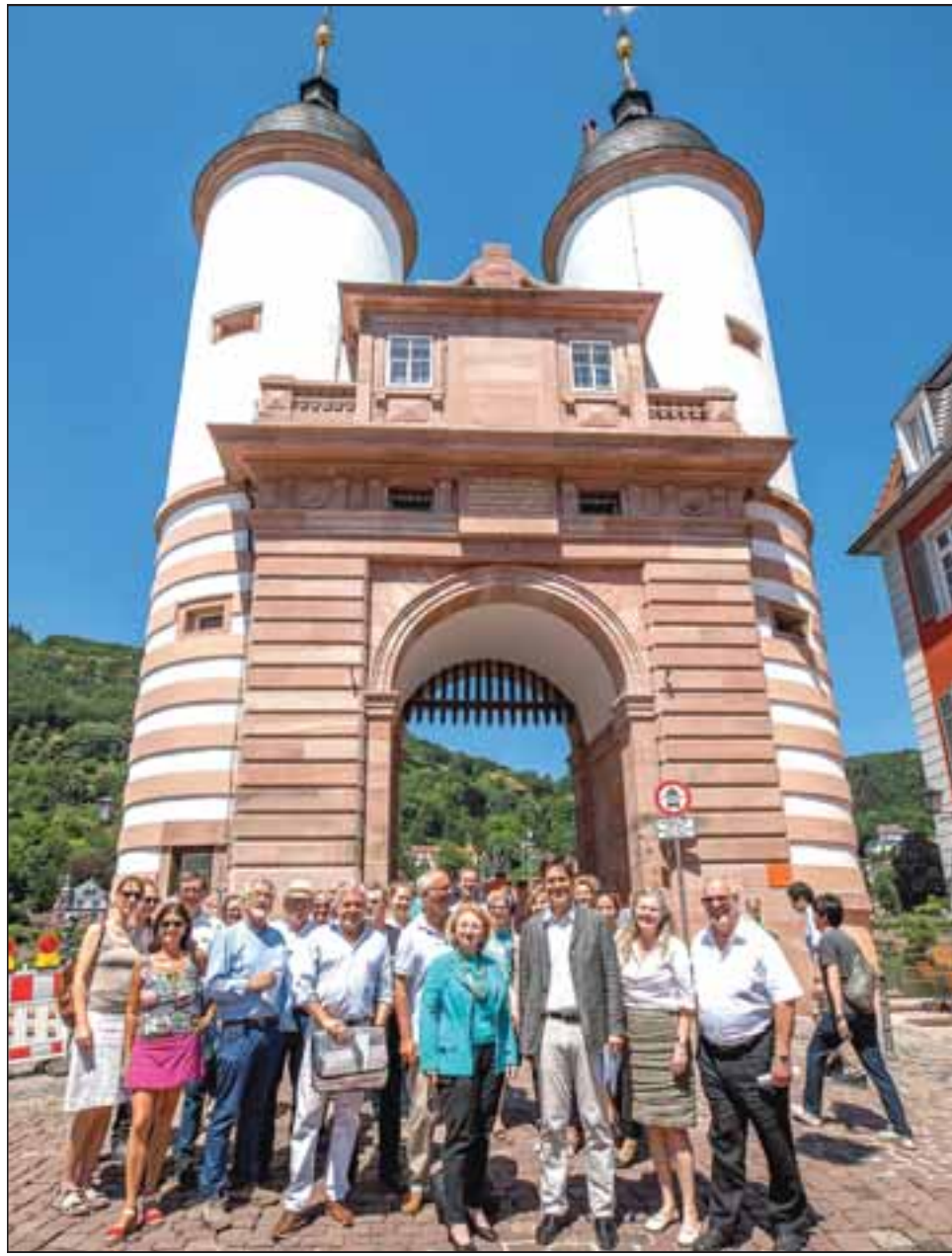
Große Feier nach mehr als zwei Jahren Arbeit: Baubürgermeister Jürgen Odszuck (der einzige mit Sakko) weihte das frisch sanierte Brückentor mit vielen Mitstreitern ein. Foto: Alex
